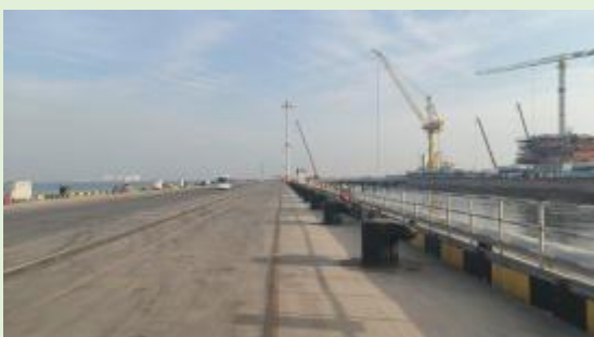
码头工程完工照片
