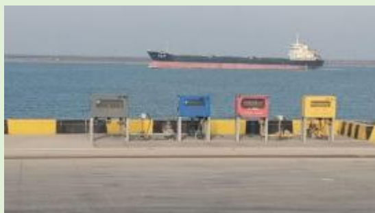
码头工程完工照片
